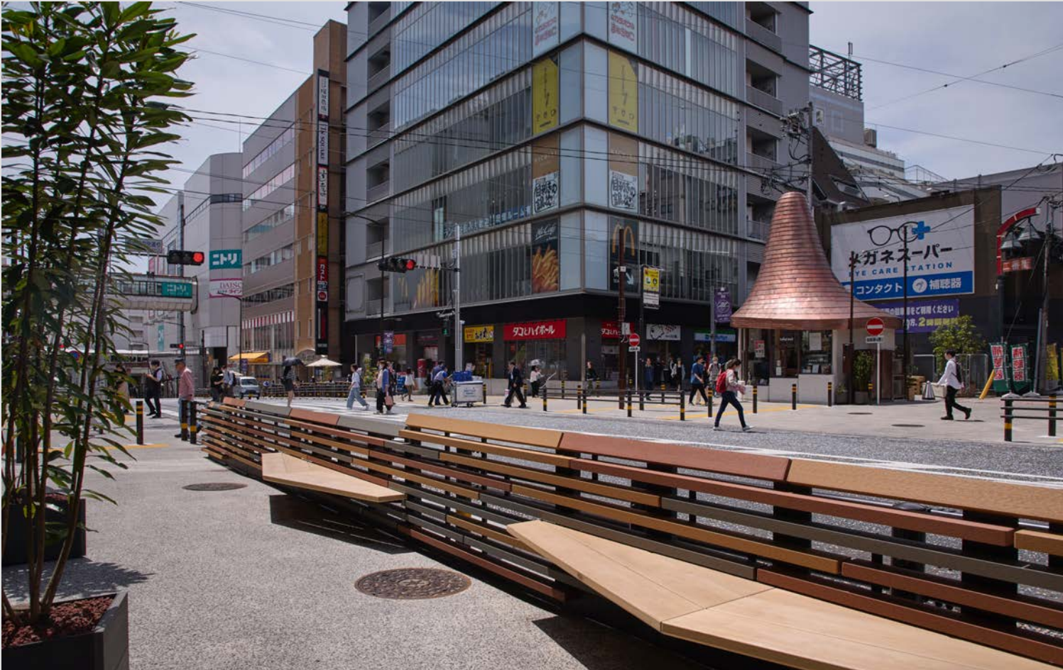
歩道拡幅部分に設けられた滞留空間「はっとterrace」、奥に見える銅葺き屋根の建物が町田市交流拠点「はっとまちだ」（建築設計：日建設計）
