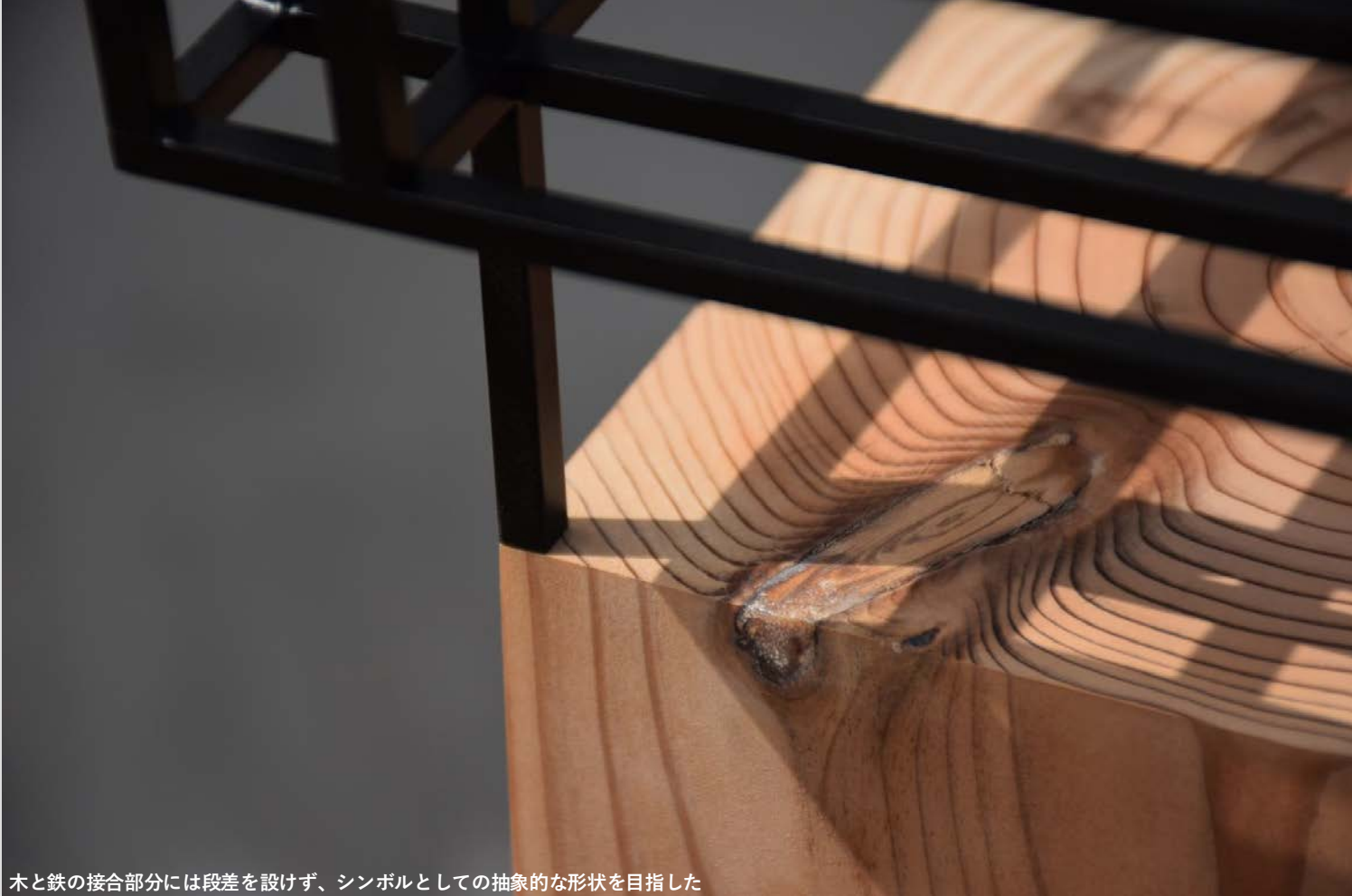
木と鉄の接合部分には段差を設けず、シンボルとしての抽象的な形状を目指した
